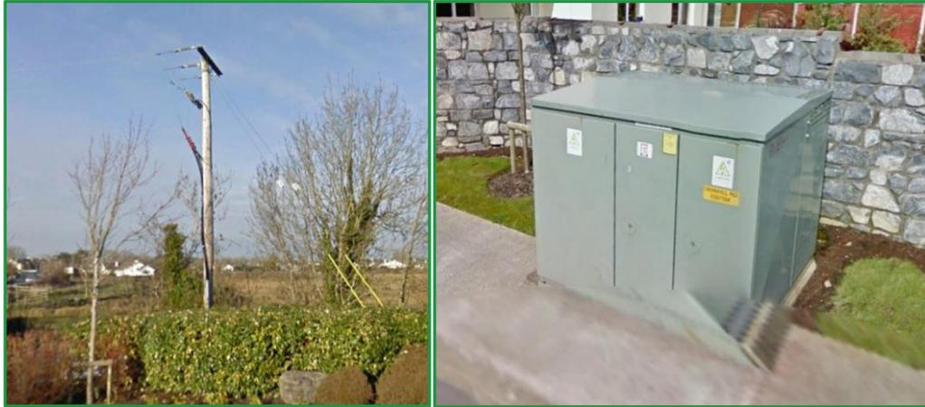
**FIGURE 22 – TRANSITION FROM OVERHEAD LINE TO UNDERGROUND CABLE AT THE EDGE OF THE EXISTING HOUSING ESTATE**
